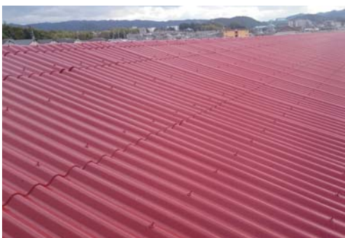
合成樹脂にバイオマス原料を加えた塗料は環境にやさしい上に接着力が高く、紫外線による劣化も抑えられる。
